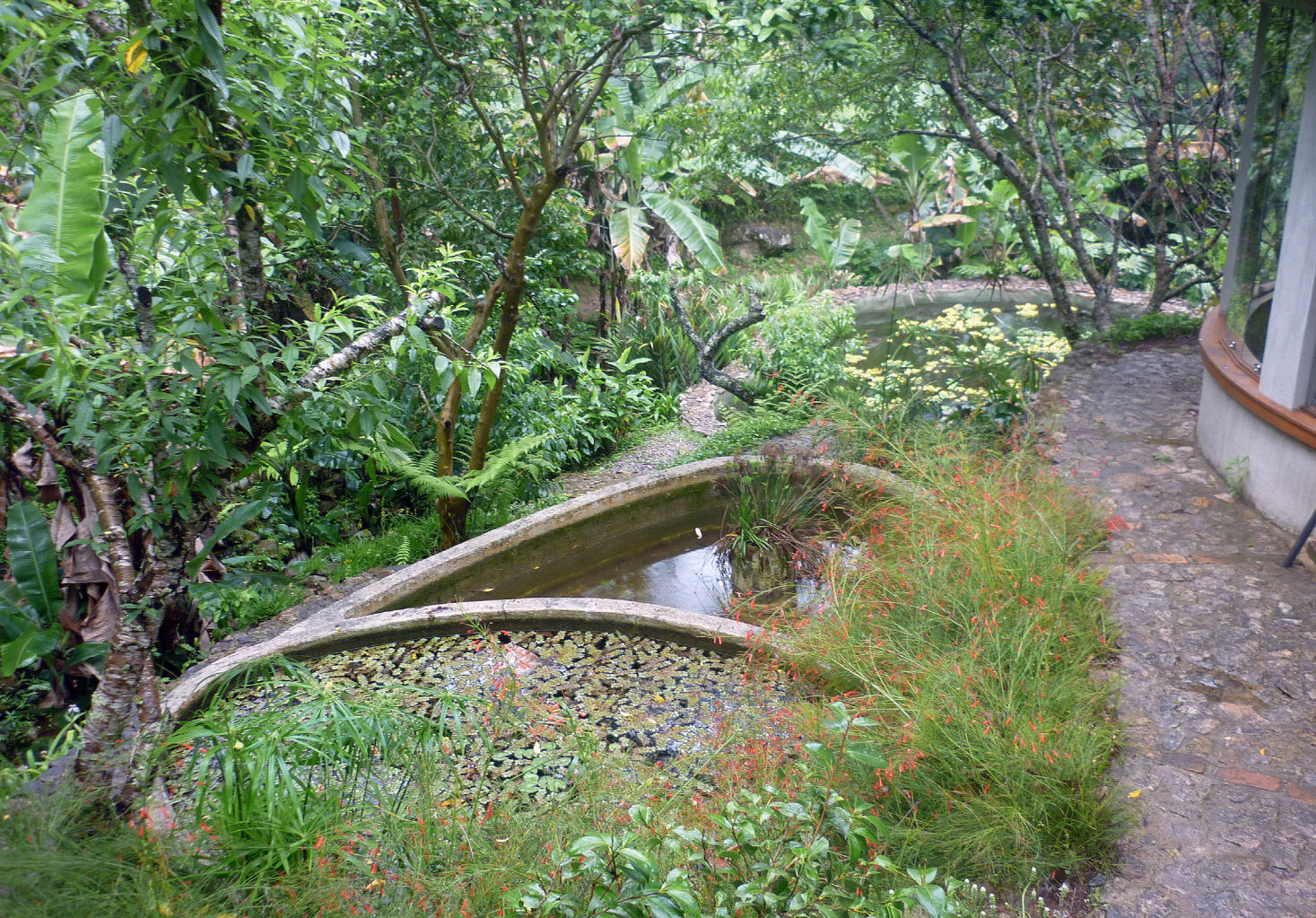
Biossistema domiciliar completo, com lagos sobre o biodigestor.
