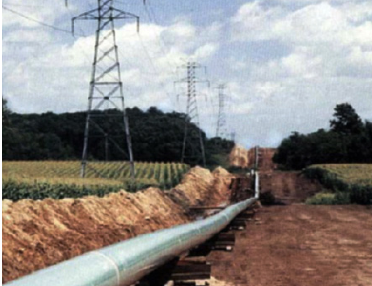
Visão panorâmica de um duto. O procedimento catódico tem fases sequenciais: isolamento elétrico, revestimento do duto com material isolante e passagem de corrente elétrica.
